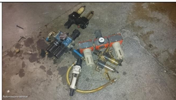
Demonterte defekte FRL enheter for utskifting.
